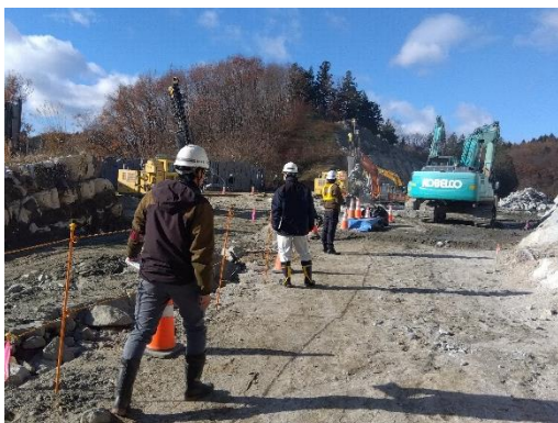
点検状況<須賀川、石川方部>
