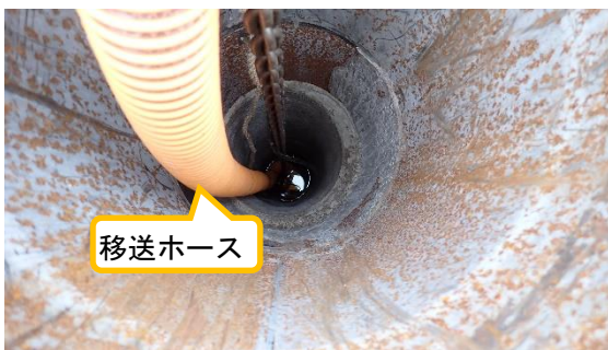
(写真2-1) ポンプ及び移送ホースが投入された 貫通孔の内側の状況
