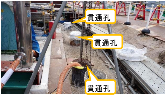
(写真1-2) 貫通孔の設置状況② (北側から撮影)
