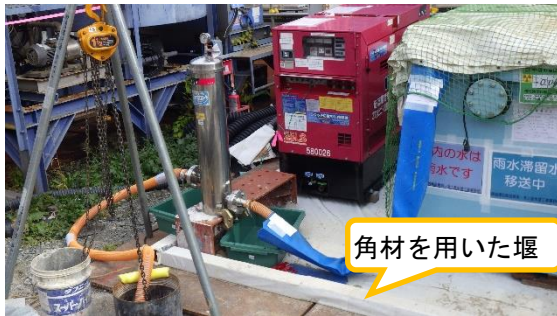
(写真4-1) 貫通孔東側ノッチタンクに設置され た堰の状況
