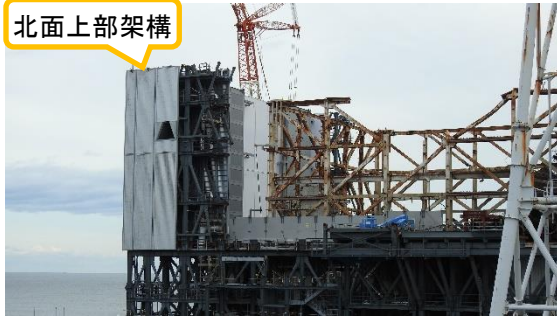
(写真5) 原子炉建屋北面における上部架構の 設置状況
