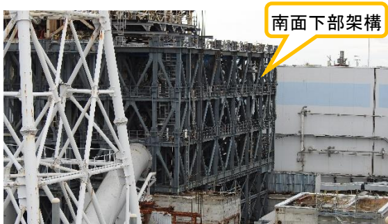
(写真 4) 原子炉建屋南面における下部架構 の設置状況
