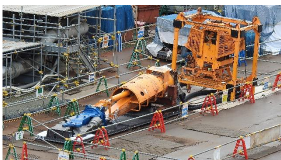
(写真 3) 外周鉄骨撤去作業に使用する吊り 下げ式カッターの仮置き状況
