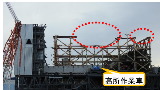
(写真1-2) 原子炉建屋西面外周鉄骨一部撤去後の状況 (令和6年12月11日撮影)
