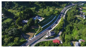
国道349号（川俣町大綱木工区） 2023年3月21日 完成
