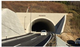
国道114号（川俣町山木屋工区開場トンネル） 2022年12月26日 供用
