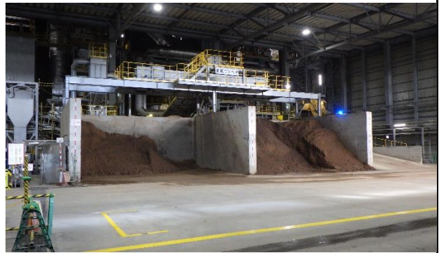
建屋内の状況（主灰の搬出ヤード） 異常なし。
