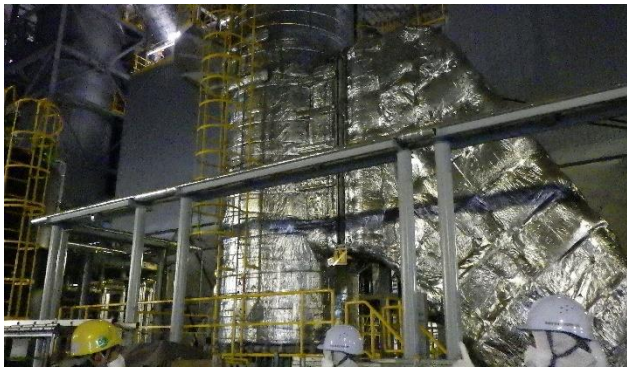
焼却施設の状況（煙突） 異常なし。
