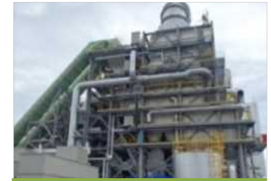
仮設焼却施設
