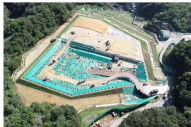
特定廃棄物埋立処分施設
