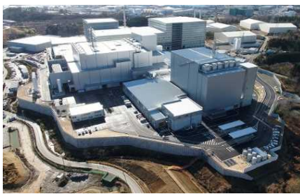
仮設減容化施設
