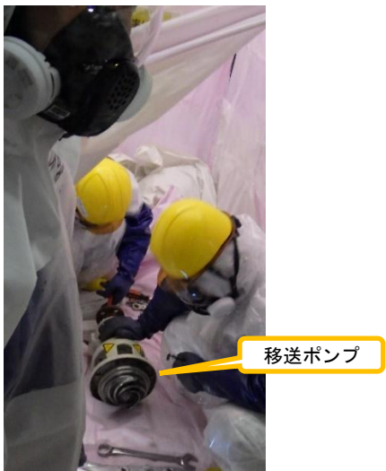
(写真 3 - 2) 排水移送ポンプの分解点検状況②
