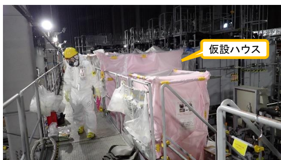
(写真2-1) 除染対象エリア周辺の状況③ ※仮設ハウス内や歩廊下部が 除染対象エリアとなっている。
