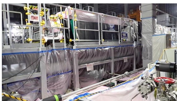
(写真1-2) 除染対象エリア周辺の状況② ※歩廊下の養生の状況
