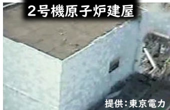
1号機の爆発の衝撃で開いたパネルから水素が外に排出されたため、爆発しなかった。
