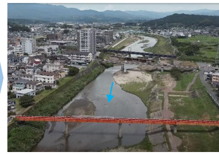
2 工区（鎌田水位観測局付近）
