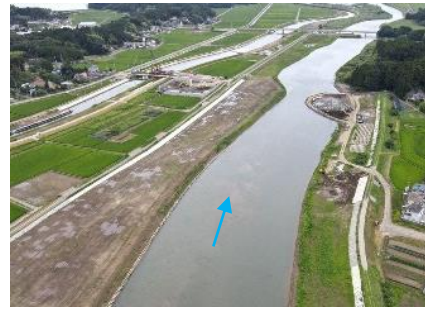
北飯淵地区（百間橋付近）
