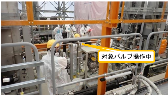
(写真1-2) 吸着剤交換に伴う系統構成の状況②
