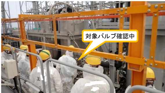
(写真1-1) 吸着剤交換に伴う系統構成の状況①
