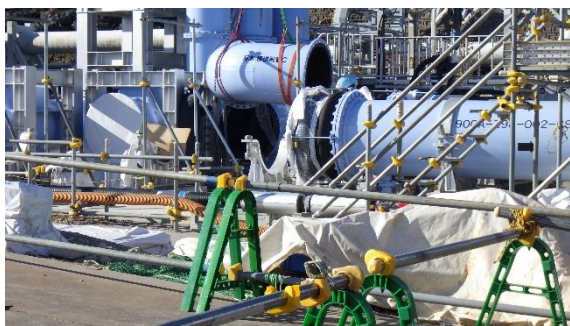
(写真2②)点検後の配管再設置作業
