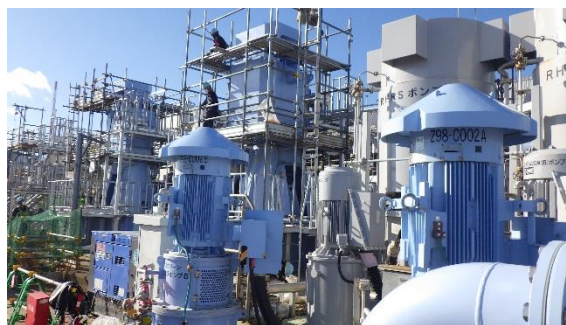
(写真2①) ポンプの点検作業
