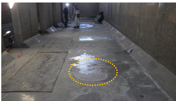
(写真1①) 補修作業の状況
