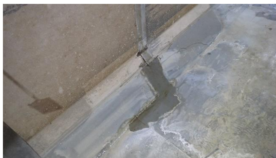
(写真1③) 側面擁壁接合部の水抜き
