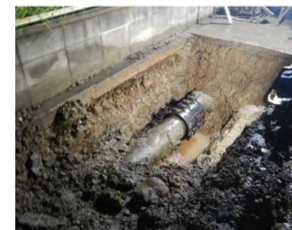
補修用ジョイント設置
