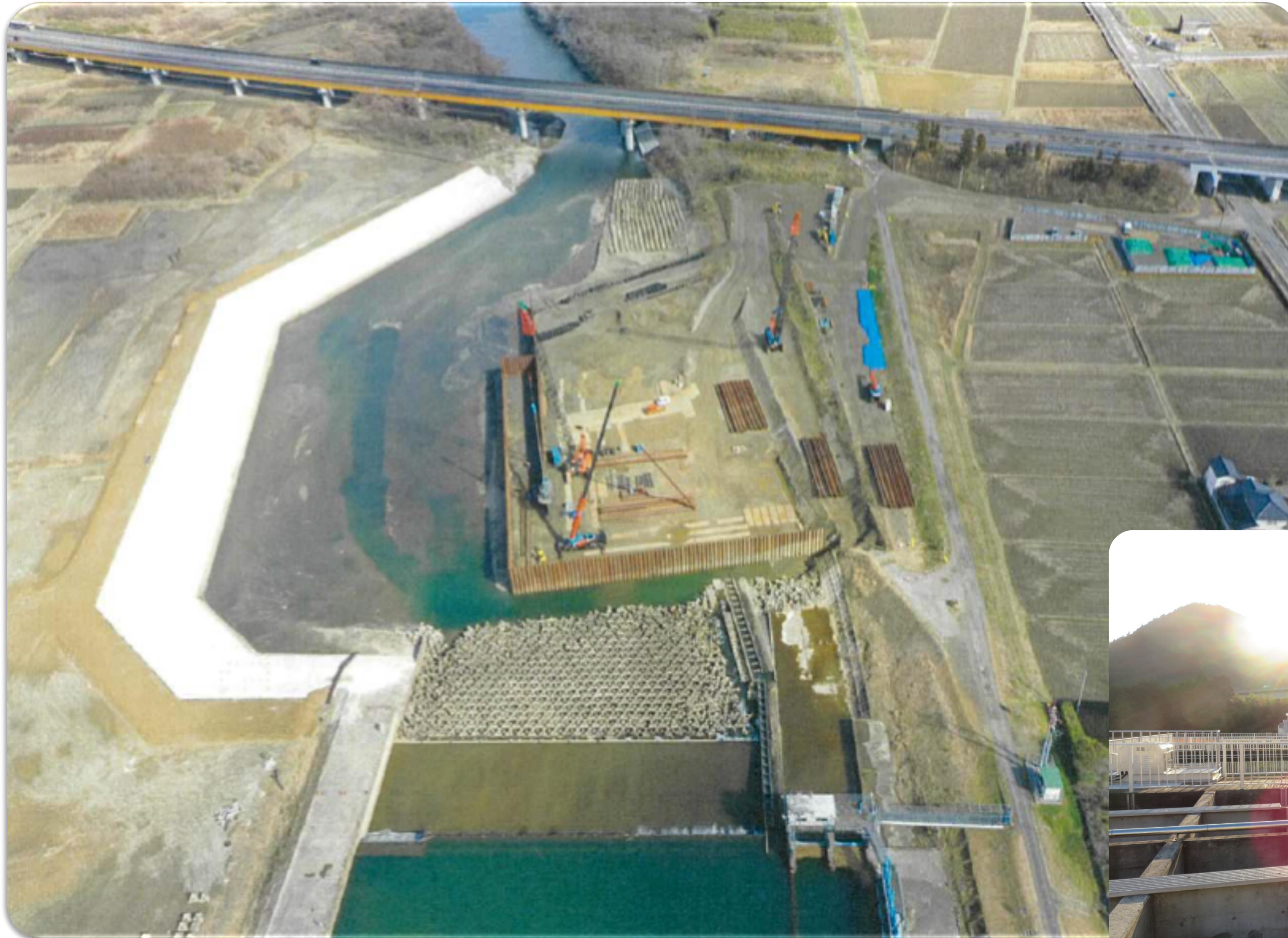
沼部堰更新工事 (R4~R10 (予定)) 【勿来工業用水道】 沼部堰については、建設から60年以上が経過しており、老朽化対策や耐震性を確保するため、新たな堰の建設を進めています。(令和6年3月時点)
