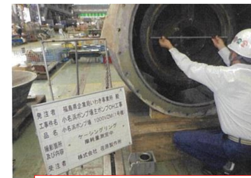
分解・点検状況
