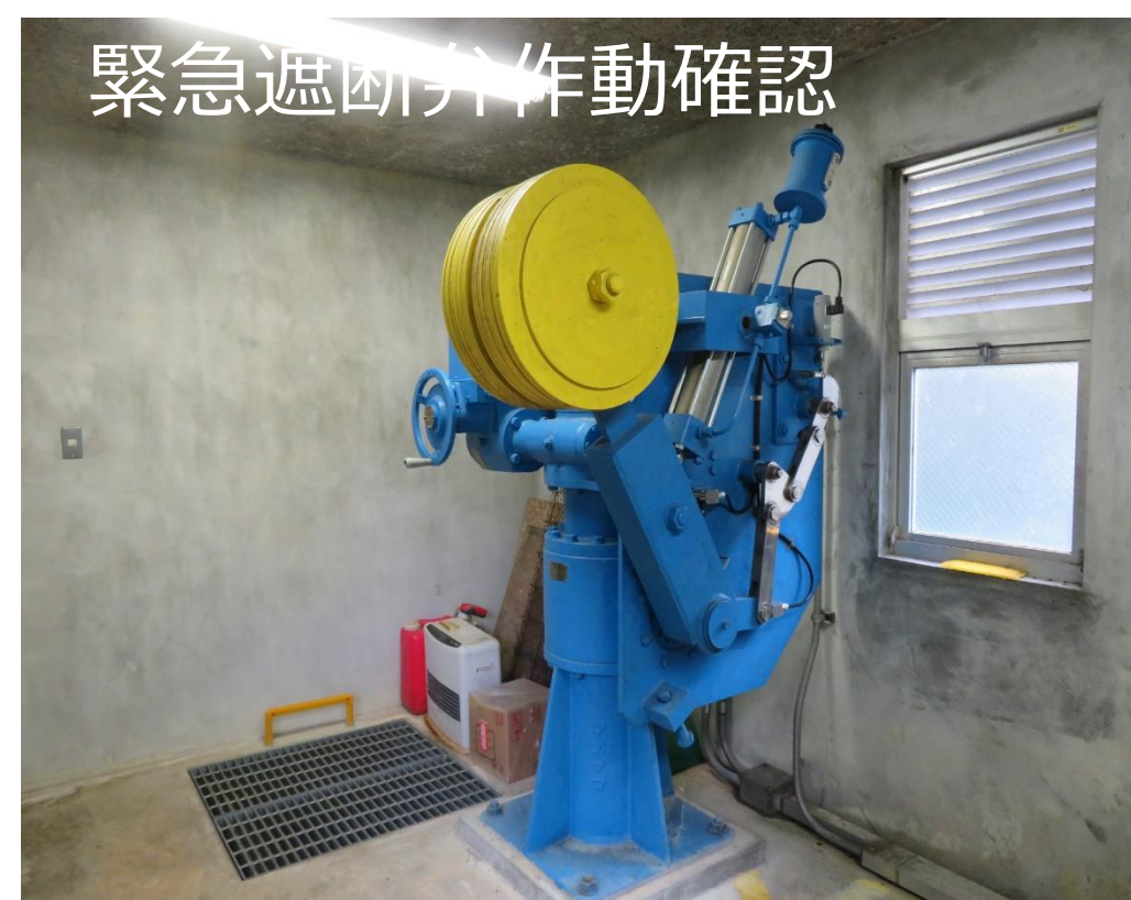
制水弁作動確認状況(導水管)
