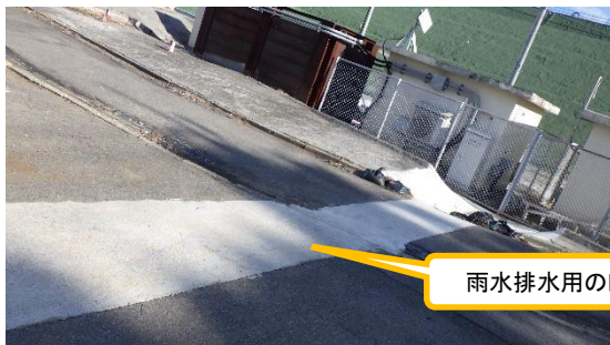
(写真 4) 局舎周辺の雨水排水用の暗渠 (白コンクリートの下部に設置)
