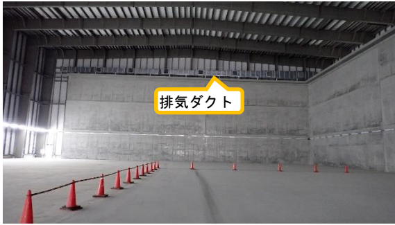
(写真 5 - 1) 建屋内南側における排気ダクトの設置状況①
