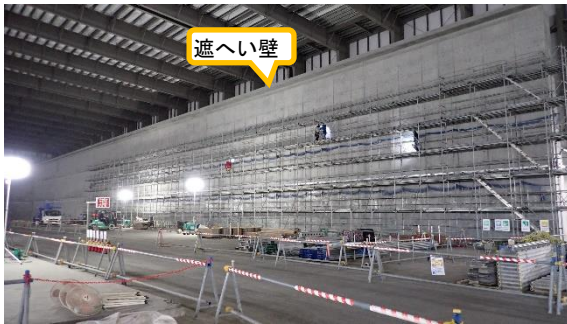
(写真3) 建屋内西側における遮へい壁の設置 作業状況
