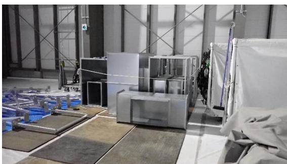
(写真4-2) 建屋内北側における給気ダクト部材 の仮置き状況
