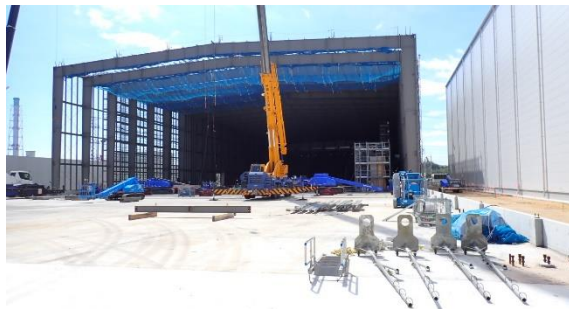
(写真1-1) 第10-C棟の外観① (北西側から撮影) (令和6年9月12日撮影)
