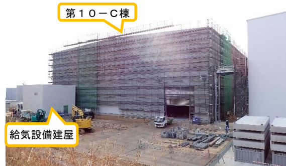
(写真1-2) 第10-C棟の外観① (北西側から撮影) (令和7年1月16日撮影)
