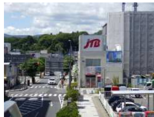
<R5.3時点 現況写真>
