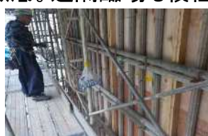
〈データロガーによる温度確認〉
