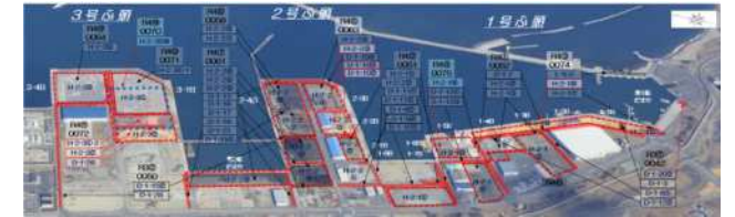
<野積場・臨港道路被災箇所>
