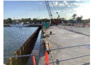
<岸壁の前出し施工状況>
