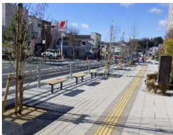
<R6.12時点 現況写真>
