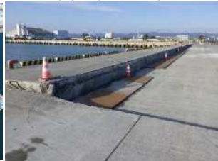
<令和4年岸壁状況>
