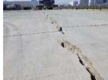
<令和3年岸壁状況>
