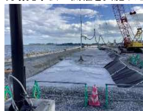
<軽量混合処理土工施工状況>
