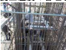
〈筒先付近の締固め〉
