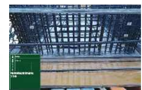
〈補強鉄筋の追加〉
