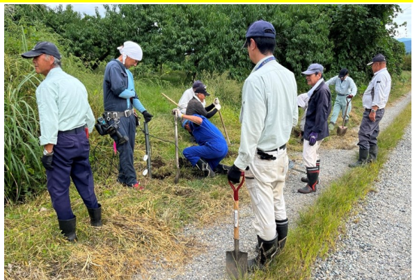
恒久電気柵の設置
