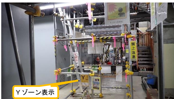
(写真 2 - 2) 電源供給盤 (M/C 6 A - 2) 付近 における作業場所へのYゾーン掲示 状況 (5号機タービン建屋地下1階)
