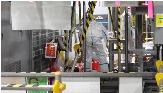
(写真 2 - 1) 電源供給盤 (M/C 6 A - 2) 付近 における電源ケーブル敷設作業の実 施状況 (5号機タービン建屋地下1階)
