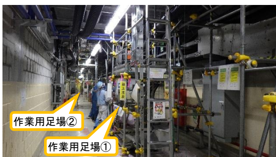
(写真1-1) 作業用足場の設置状況 (6号機タービン建屋地下1階)
