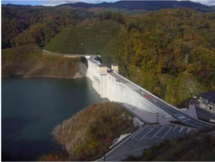
木戸ダム（檜葉町）
