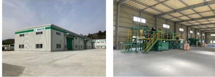
太陽光パネルリサイクル施設（提供：㈱高良）
