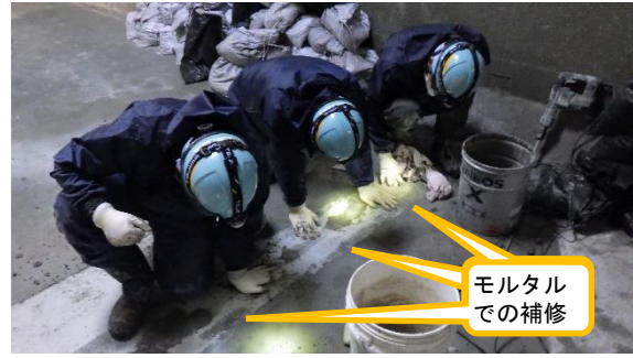
(写真1④) 止水作業の状況
