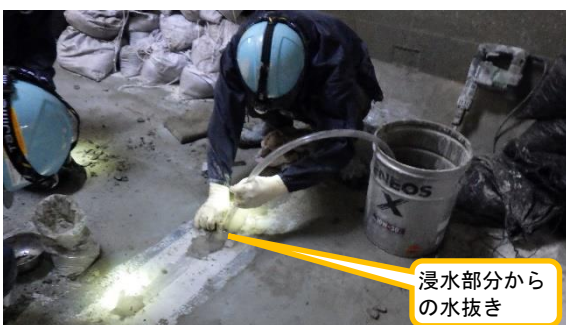
(写真1③) 止水作業の状況
