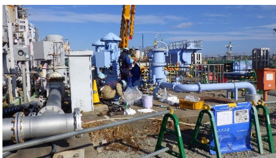
(写真2①) スクリーン点検作業
