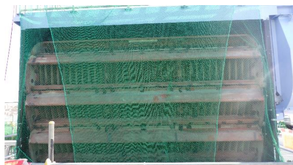
(写真2②) 点検中のスクリーン
