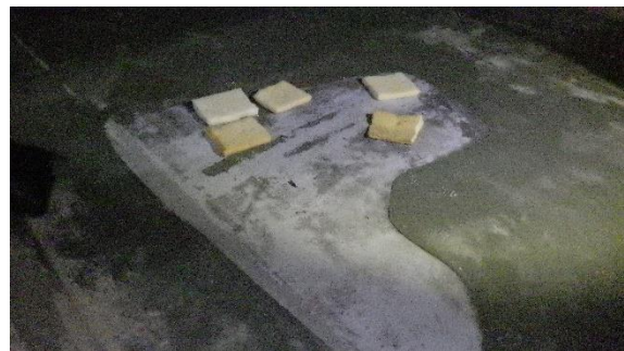
(写真1②) 水抜作業の状況
