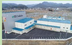
営農再開に向けた施設整備
