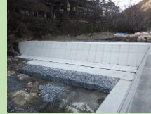
老朽化した頭首工の補修
