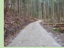
森林作業道の開設
