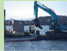
漁場内のがれき等の除去作業
