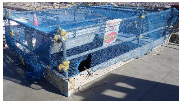
(写真1②) 足場が設置されていた開口部
