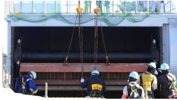
(写真3③)スクリーンの組立作業
