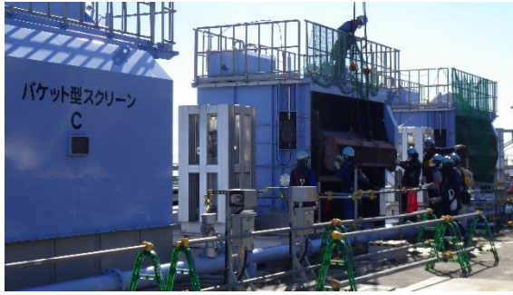
(写真3②)スクリーンの組立作業
