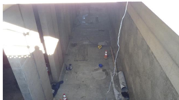
(写真1④) 上流水槽内部の状況(北側)
