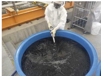
吸着材交換作業
