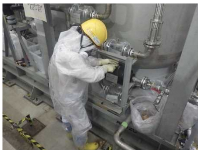
吸着材逆洗作業
