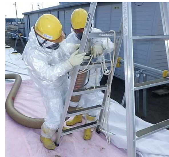
脚立へのホース端部固定作業状況
