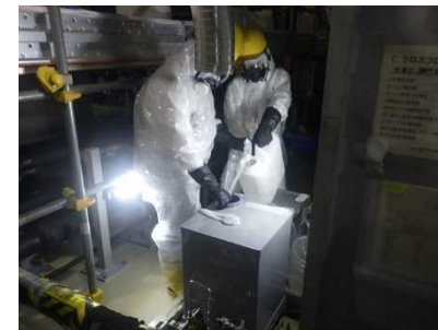
クロスフローフィルター洗浄作業
