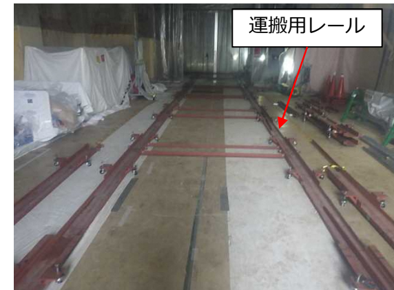
<運搬用レール敷設状況>
