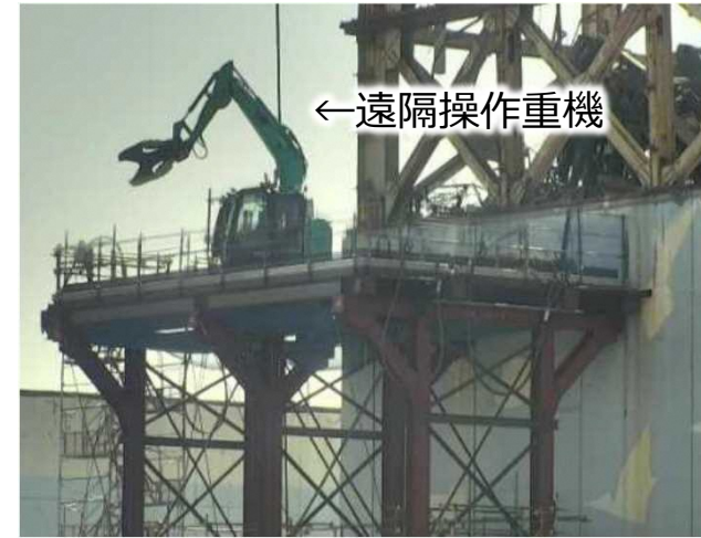
<BPL取付用の鉄骨架台>
