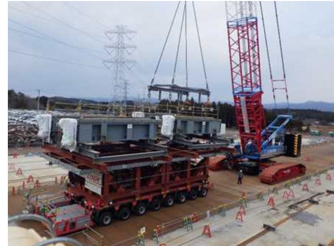
<西門ヤードでのRGブロック積込状況>
