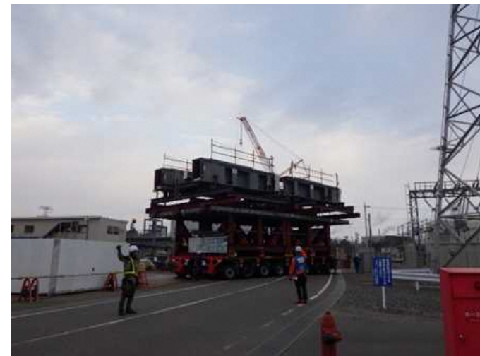
<RGブロック運搬状況>
