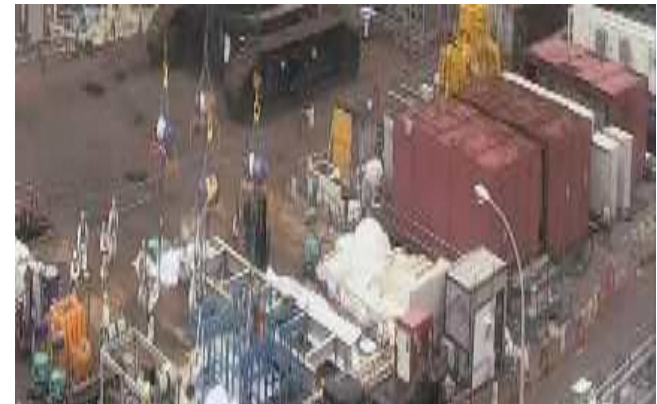
<原子炉建屋北西側作業エリア>
