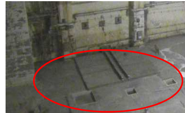
<2号機原子炉建屋内遮蔽コンクリート打設後の状況>
