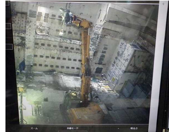
<2号機原子炉建屋内遠隔重機作業状況>
