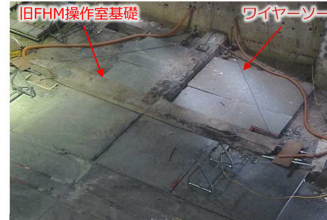
< 2号機原子炉建屋内旧FHM操作室基礎 >
