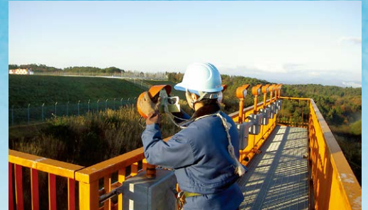
航空灯火の点検
