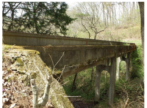
三ツ森幹線用水路 水路橋
