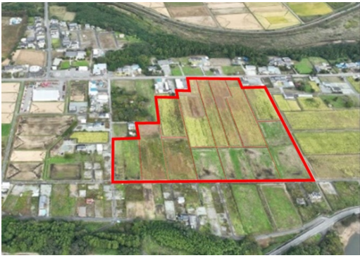
整備前の加倉地区
