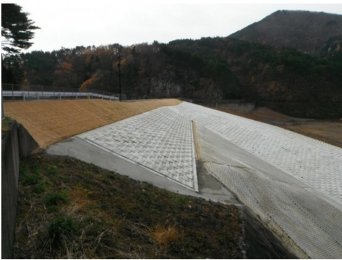
三ツ森溜池 平成27年11月災害復旧事業完成
