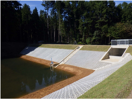
防災工事の例（会津若松市）
