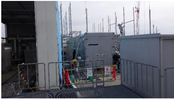
(写真 1-1) 現在取替工事が実施されている窒素 ガス分離装置 C の工事実施状況
