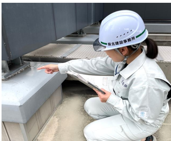
↑現場確認の様子
