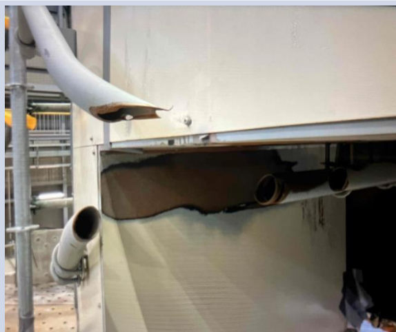
電線管撤去(C)
