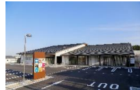
大熊町：商業施設
