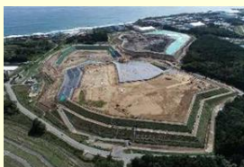
中間貯蔵施設の様子
