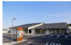
大熊町：商業施設
