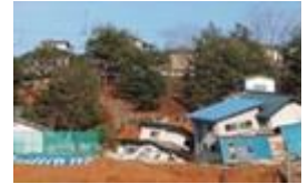
家屋被害：福島市
