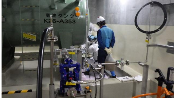
(写真5—1) 抜油作業の状況①
