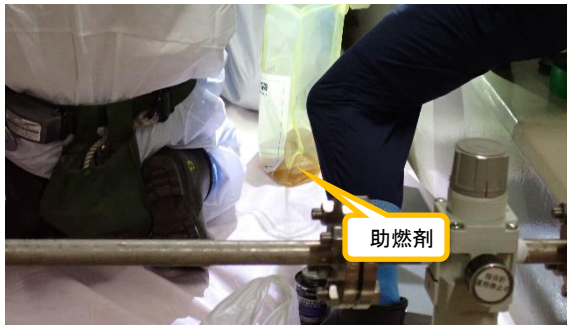
(写真5—2) 抜油作業の状況②
