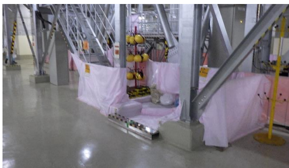
(写真 4—2) 汚染拡大防止措置の状況
