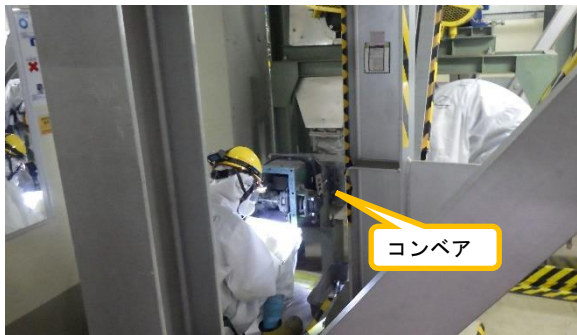
(写真 4—1) 灰搬送コンベアの点検状況
