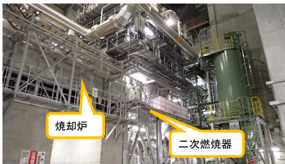
(写真 3) 設備（焼却炉等）の設置状況
