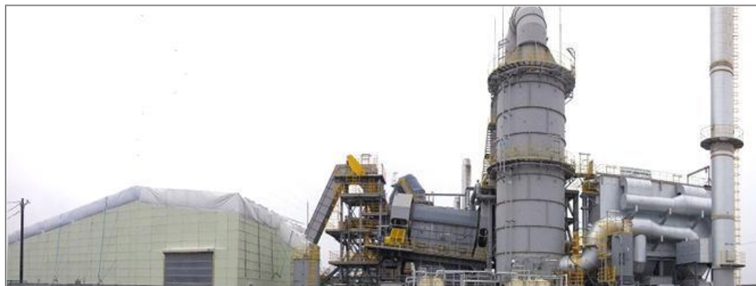
仮設焼却施設の例（相馬市）
