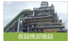
仮設焼却施設
