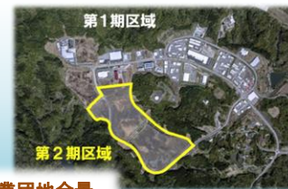
工業団地全景
