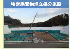
特定廃棄物埋立処分施設
