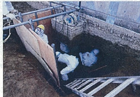
写真1 当日作業開始時
