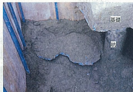
写真2 土砂と共に崩落した均しコンクリート
