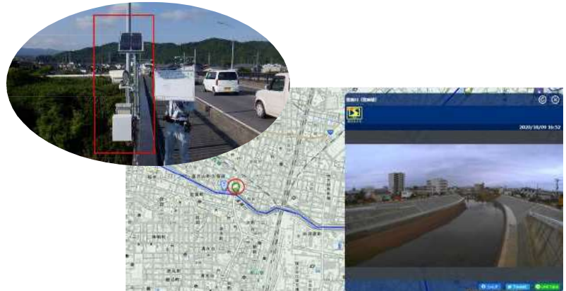
簡易型河川監視カメラ型の設置
