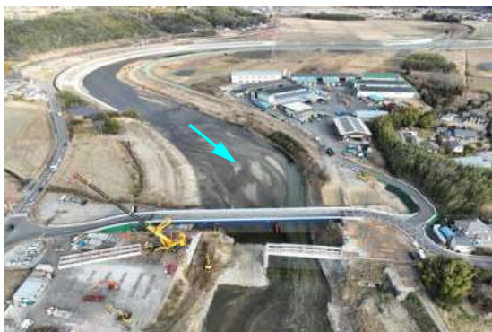
夏井川 河川改修事業（整備状況）
