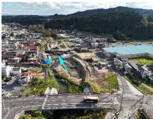
右支夏井川 河川改修事業（整備状況）
