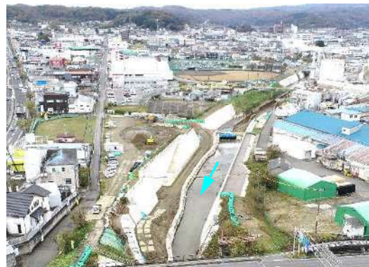
濁川 河川改修事業（整備状況）
