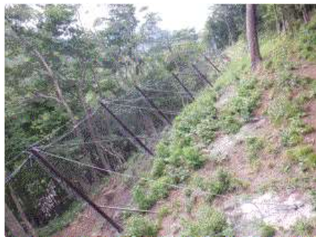
法面对策状況 (国) 118号<天栄村>
