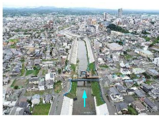
逢瀬川 河川改修事業（整備状況）
