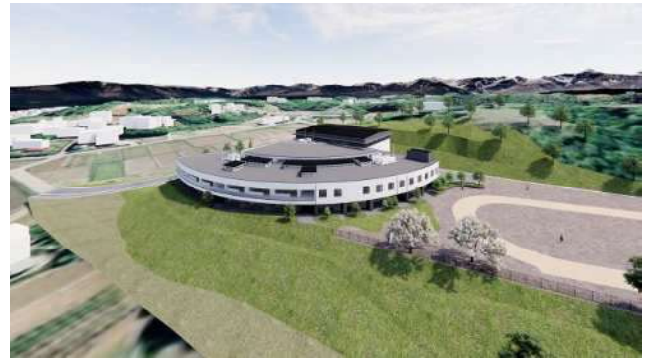
■あだち支援学校二本松校舎（二本松市） 【工事中、令和7年5月竣工予定】
