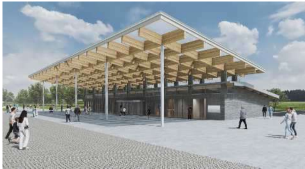
■復興祈念公園管理棟（双葉町） 【工事中、令和7年10月竣工予定】
