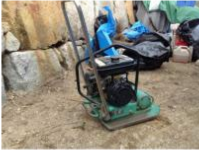
転圧機（振動コンパクト）
