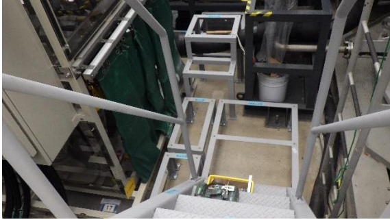
(写真4)歩廊の設置
