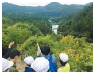
第一只見川橋りょうビューポイント
