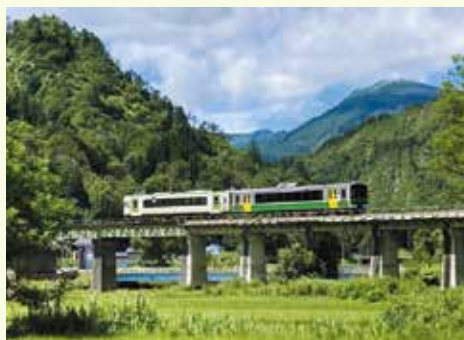
叶津川橋りょう
