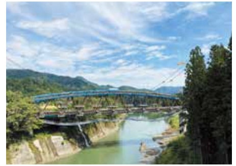
復旧工事(第7只見川橋りょう)
