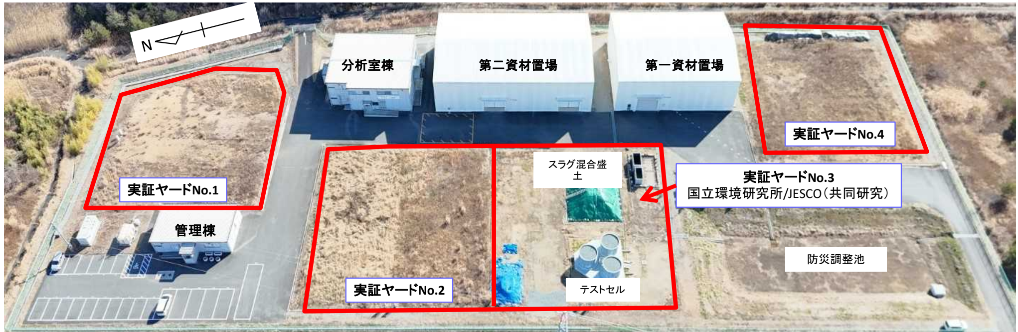
ドローンによる技術実証フィールド全景(2025年2月4日時点)
