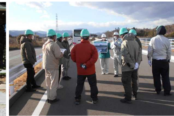
大熊工区 道路盛土実証
