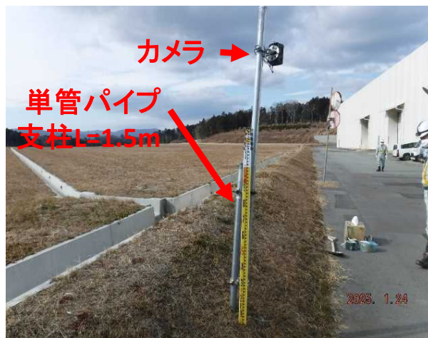
【防犯カメラ全景】
