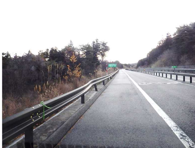
【ガードレール損傷箇所】
