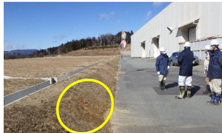
遮水シート損傷箇所（1月31日）
