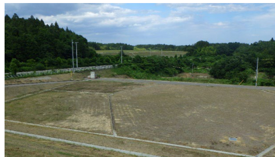
土壌貯蔵施設の状況
