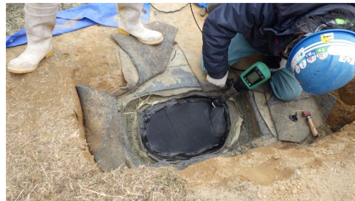
遮水シートの補修作業の様子（2月12日）
