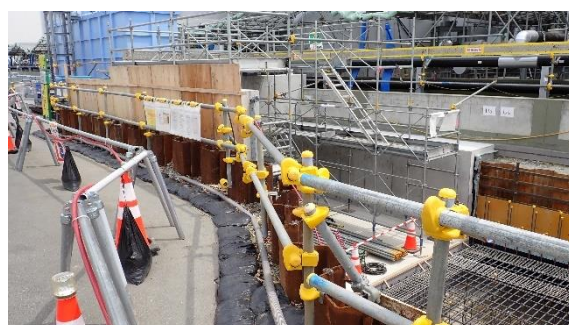
(写真 5－2) 外堰拡張工事（K 4 タンクエリア北 西側）の状況（令和 7 年 5 月 1 6 日）
