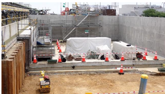
(写真 5－4) 外堰拡張工事（K 4 タンクエリア南側）の状況
