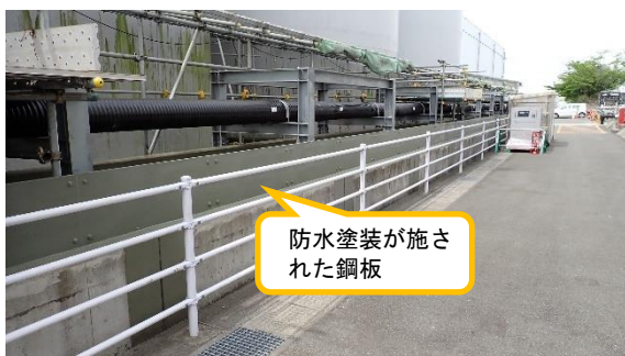
(写真 6) 外堰嵩上げ工事の状況（K 4 タンクエリア北側）
