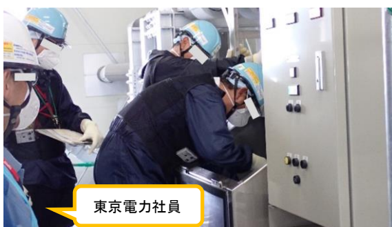
(写真 3 - 1) 東京電力社員による現場確認時の状況①
