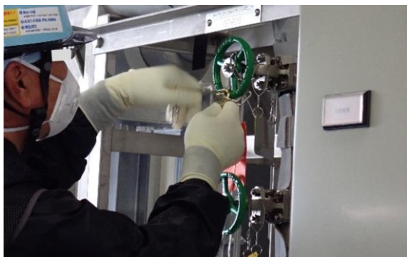
(写真 4－2) 南京錠による施錠の状況
