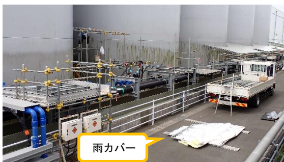
(写真 7) 雨カバー取外し作業の状況
