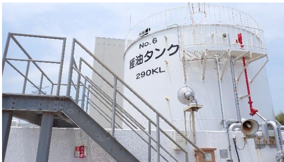
(写真 1－2) No. 6 軽油タンクの概観 (北東側から撮影)
