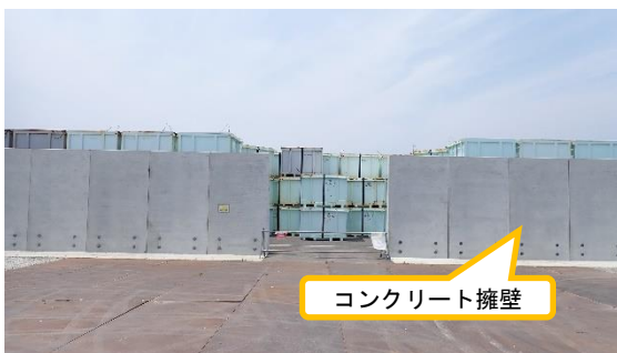
(写真4－2) 一時保管エリアA2の外観
