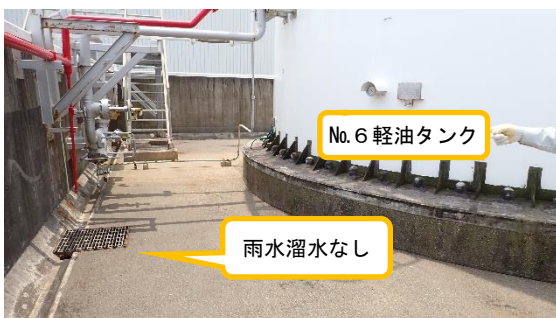
(写真 2－2) No. 6 軽油タンクの防油堤内の状況 (南側から撮影)
