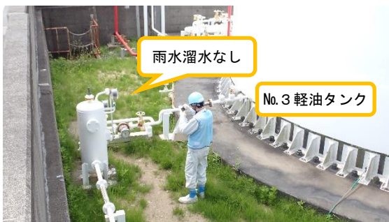
(写真 2－1) No. 3 軽油タンクの防油堤内の状況 (南東側から撮影)
