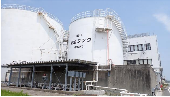
(写真 1－1) No. 3 軽油タンクの概観 (南東側から撮影)
