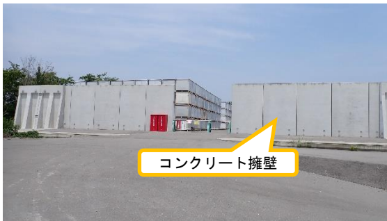
(写真4－1) 一時保管エリアA1の外観
