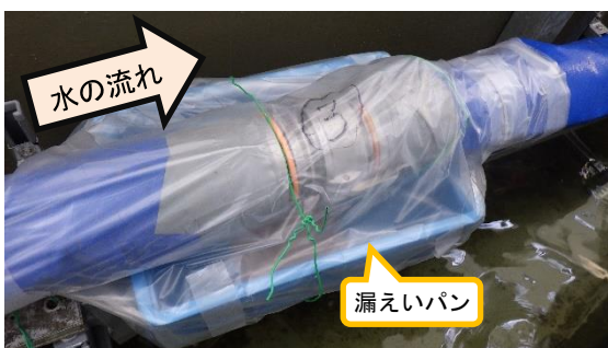
(写真 2－2) 移送ホースの敷設状況②
