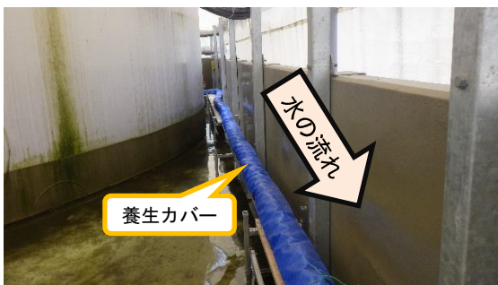
(写真 2－1) 移送ホースの敷設状況①
