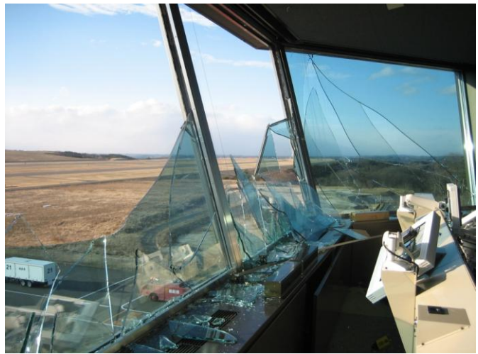
管制塔のガラス破損
