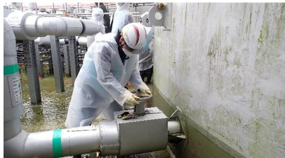
(写真1②) 連結弁の全開作業
