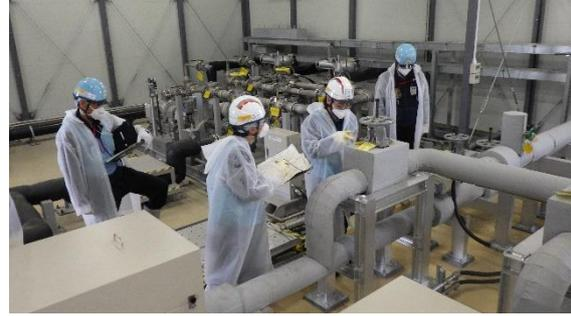
(写真1④) 多核種移送設備建屋での弁操作
