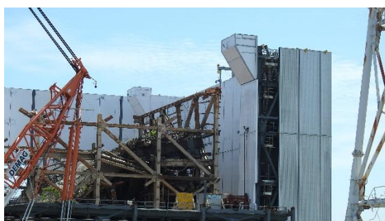
(写真1③) 建屋南側
