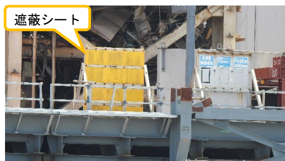
(写真2) 遮蔽シートの設置
