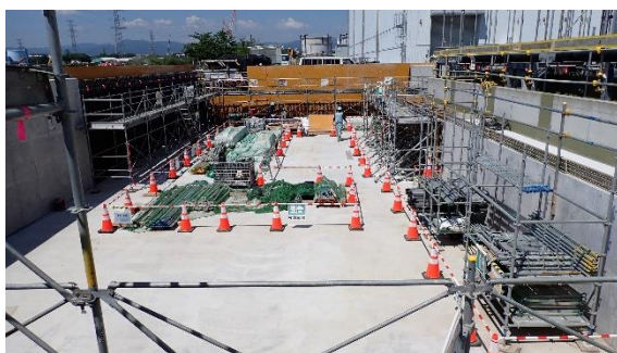
（写真1③）外堰拡張工事の状況（南側）
