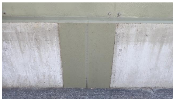
(写真3) 外堰接合部の防水対策
