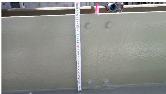
(写真2②) 外堰嵩上げの状況
