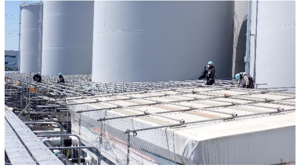
(写真 8) 屋根骨組組立作業の状況
