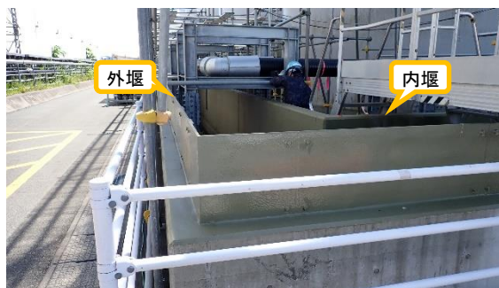
（写真2①）外堰嵩上げの状況（北西側）
