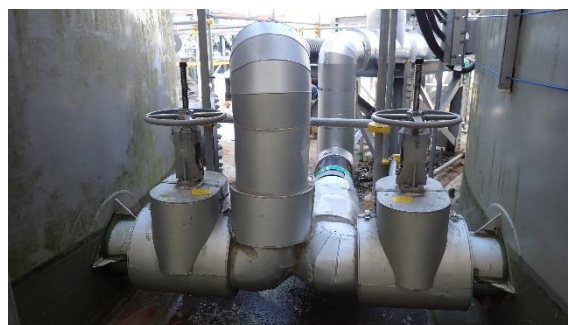
(写真5③) 入口弁の状況
