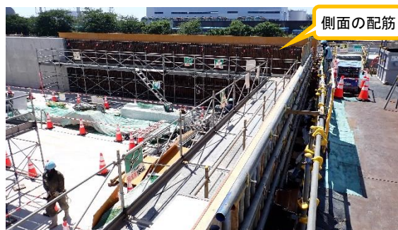
（写真1②）外堰拡張工事の状況（南西側）
