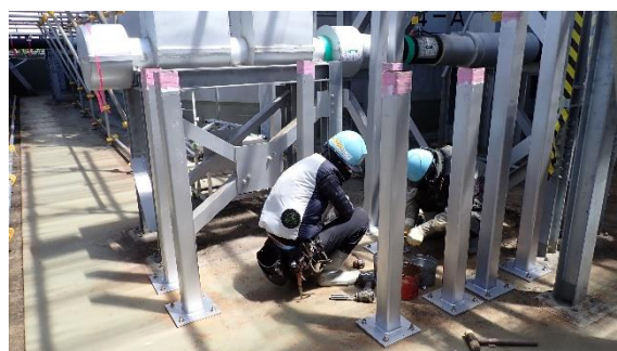
(写真6) 歩廊設置作業の状況
