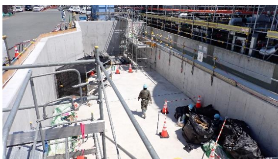
（写真1①）外堰拡張工事の状況（西側）
