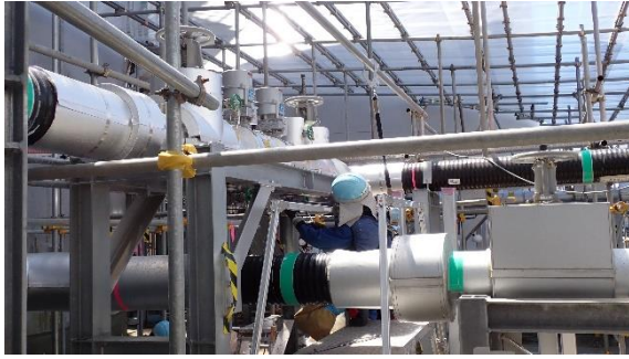
(写真 7) 保温板金設置作業の状況
