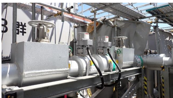
(写真5②) 払出弁の状況
